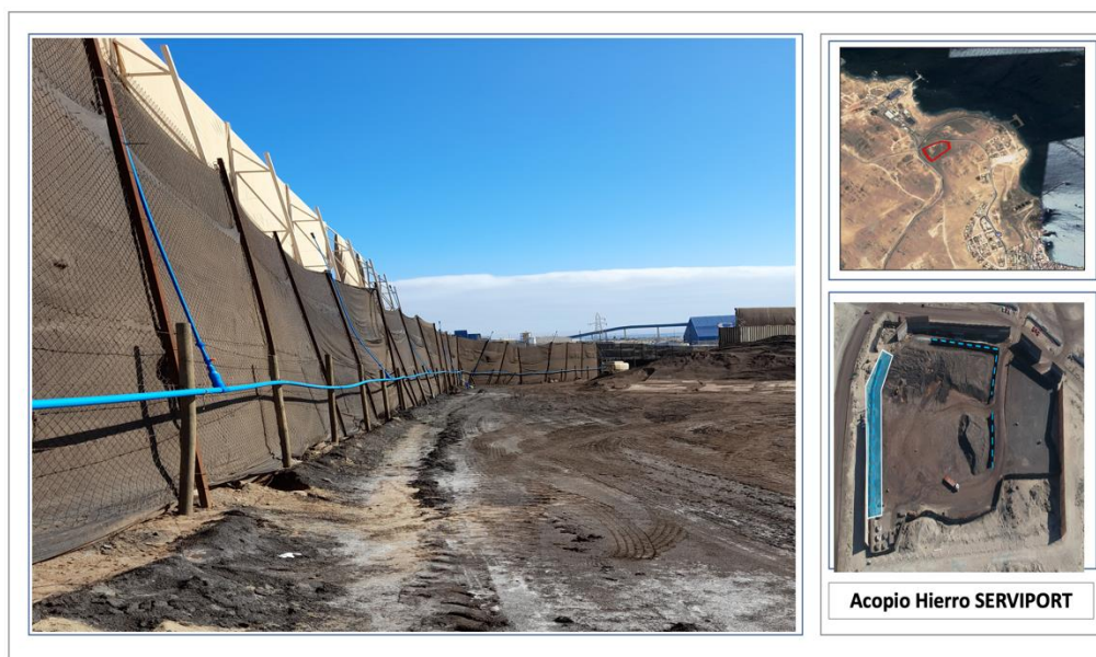
Imagen 9. Sistema de Aspersores Existentes Cara E
